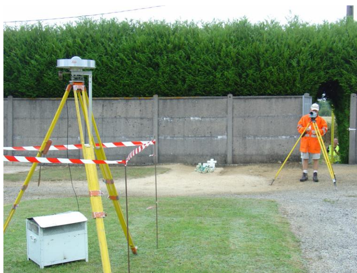
Entretien du réseau de nivellement
